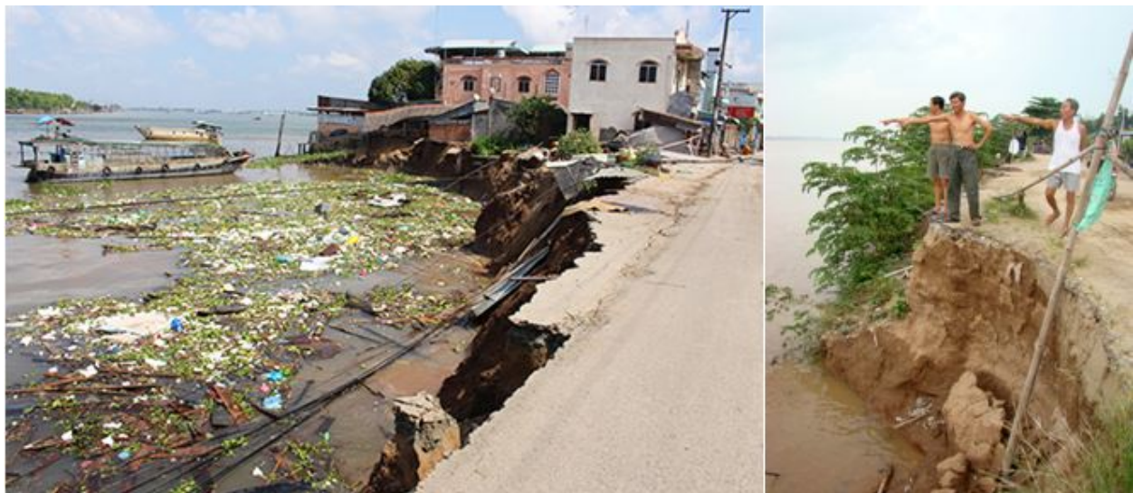
Hình 10: Với hơn 600 km bờ sông các tỉnh Miền Tây đang bị sạt lở; hình trái, Sông Hậu tỉnh An Giang với nhiều khúc bờ sông bị sạt lở do nhiều yếu tố nhân tai: mất lượng phù sa do hồ chứa nơi những con đập thủy điện
